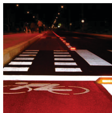
Aplicação de ciclofaixa e tachões Palhoça-SC
