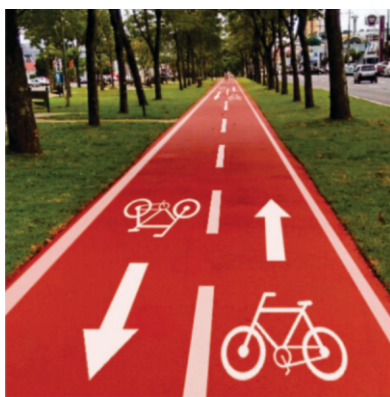
Aplicação de ciclovias Cascavel-PR
