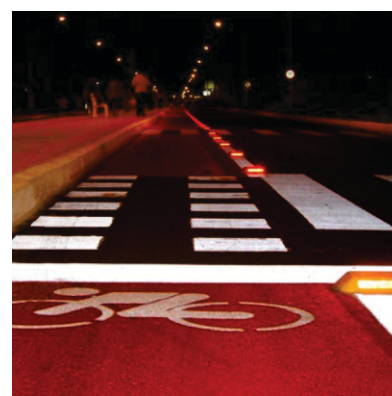
Aplicação de ciclofaixa e tachões Palhoça-SC
