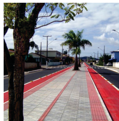
Aplicação de ciclovias Palhoça-SC
