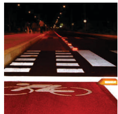
Aplicação de ciclofaixa e tachões Palhoça-SC
